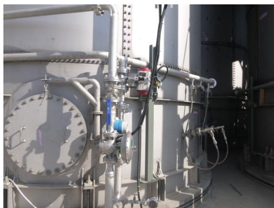
Рисунок 3 - Эжекторные трубы HyperSparge - Проект GPM Gold
