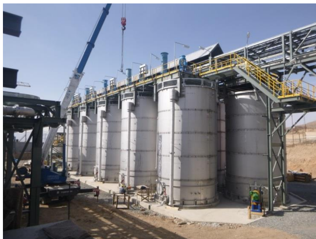
Рисунок 4 - Цикл окислительного выщелачивания - Проект GPM Gold
