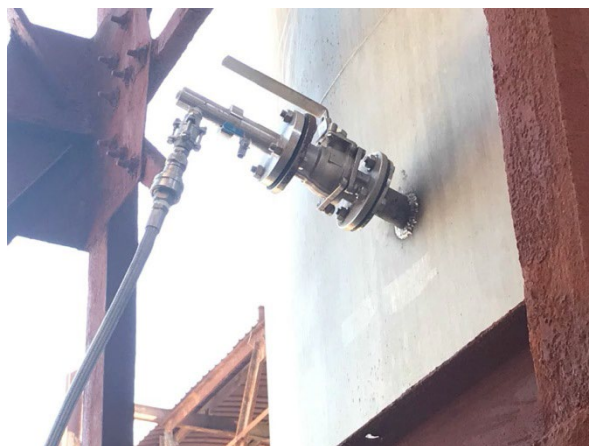
Figura 4 –HyperSparge™ de GT instalado
