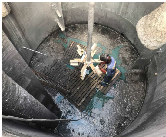
Figura 5 – Instalación agitador de dispersión de gas
