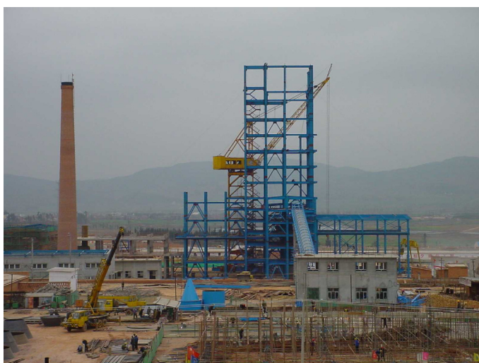
图六 云南曲靖铅锌冶炼厂建设中的艾萨铅炉
