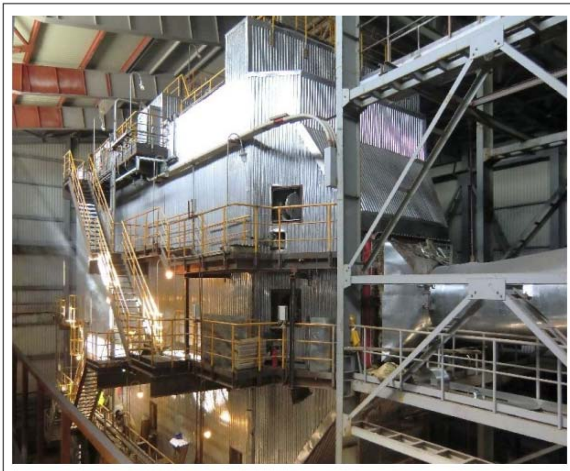
Рисунок 4: Электрофильтр на свинцовом заводе
